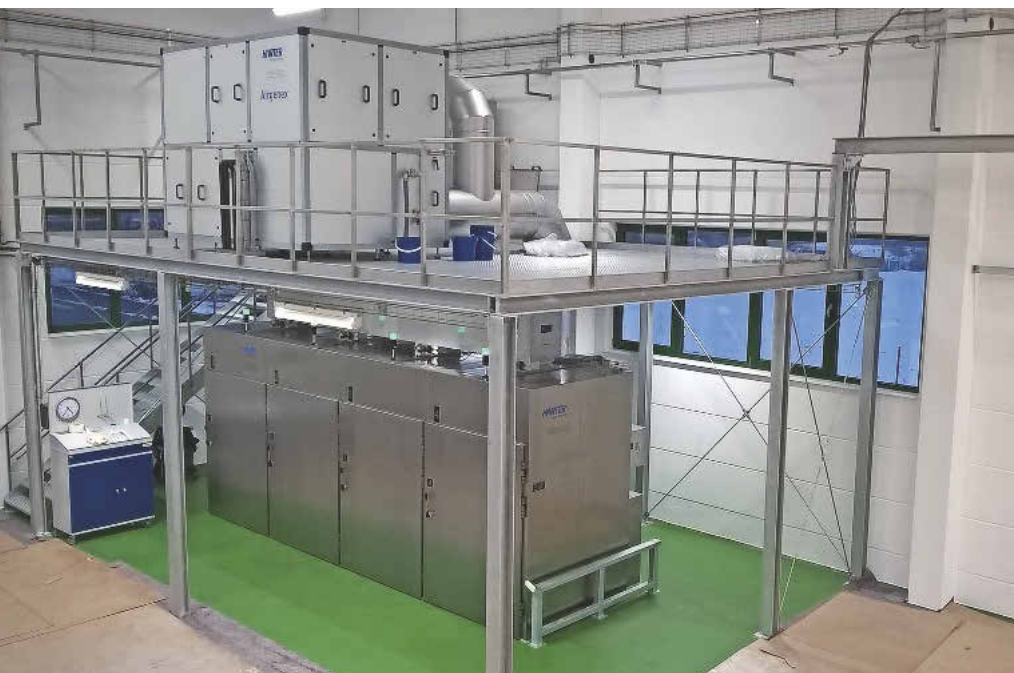
Die von Harter realisierte Kondensationstrocknungsanlage für Mandeln arbeitet nach dem Airgenex-Food-Verfahren. Sie trocknet 2 t Mandeln in 4 Stunden.
