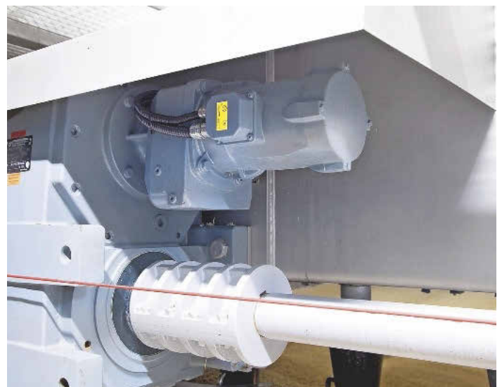
Die von Nord für die Fahrtriebe konfigurierten Antriebssysteme müssen über 7,5 t schwere Wender bewegen. Die Frequenzumrichter sind im Schaltschrank untergebracht.
