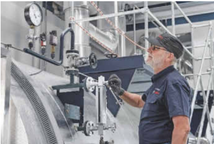
Die Inbetriebnahme der Dampfkesselanlage sowie die Begleitung der Behördenabnahme erfolgten durch den Bosch-Industrieservice
