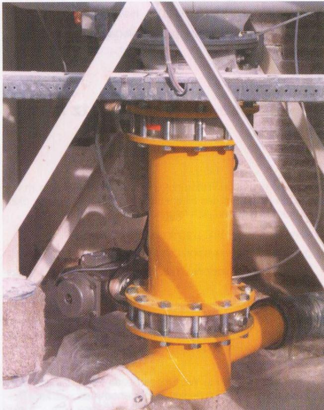
Taktschleuse zur Einspeisung von Quarzsand in eine pneumatische Förderleitung
