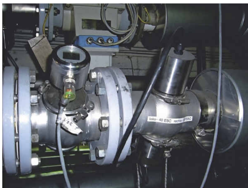
Der Trübungssensor STS01, hier montiert in der Förderstromleitung einer Brauerei, liefert so präzise und wiederholgenaue Messwerte, dass diese direkt zur Prozesssteuerung verwendet werden können
