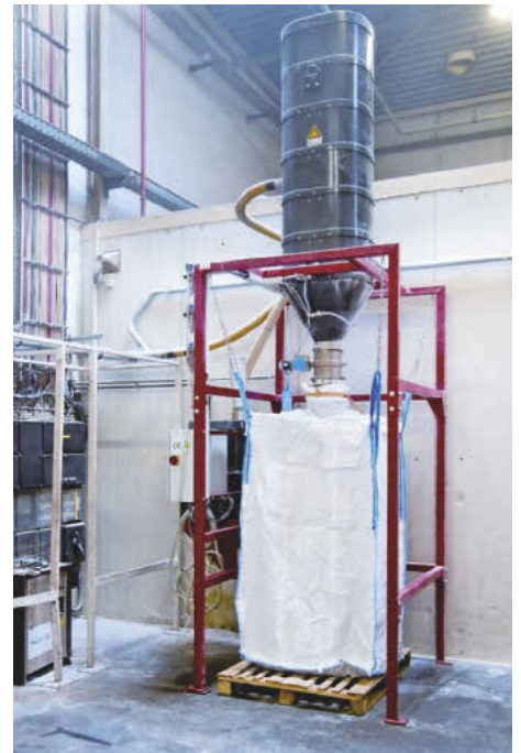
Alternative zu mobilen Saugern: Zentrale Absauganlage mit Big-Bag
